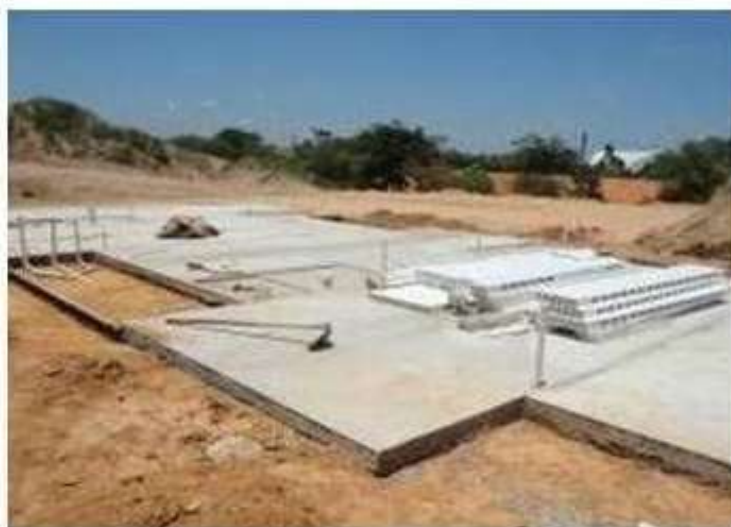
FIGURA 08 – Elemento de fundação com planicidade adequada
