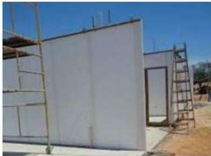
FIGURA 11 – Painéis de PVC posicionados e escorados
