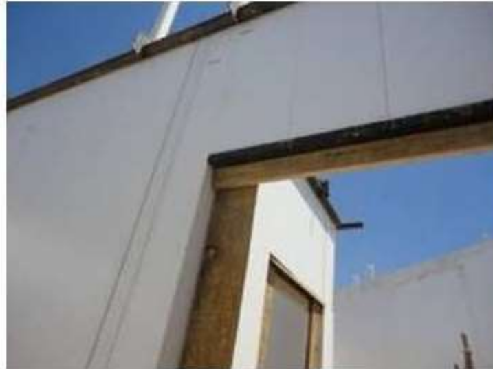
FIGURA 13 – Escoramento de aberturas de portas para concretagem
