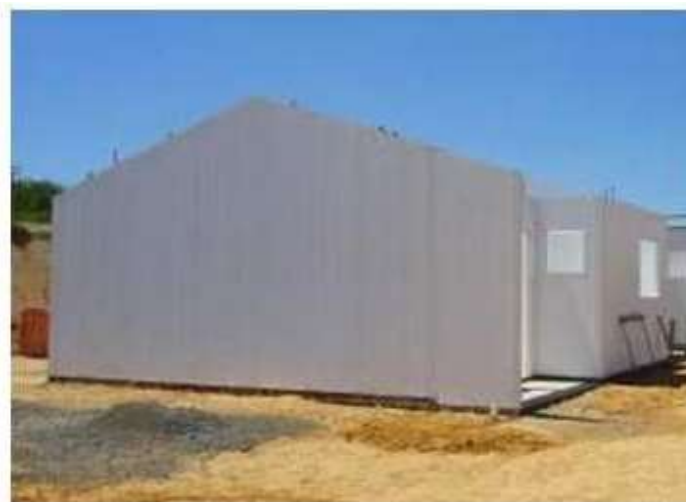
FIGURA 14 – Painéis de PVC concretados
