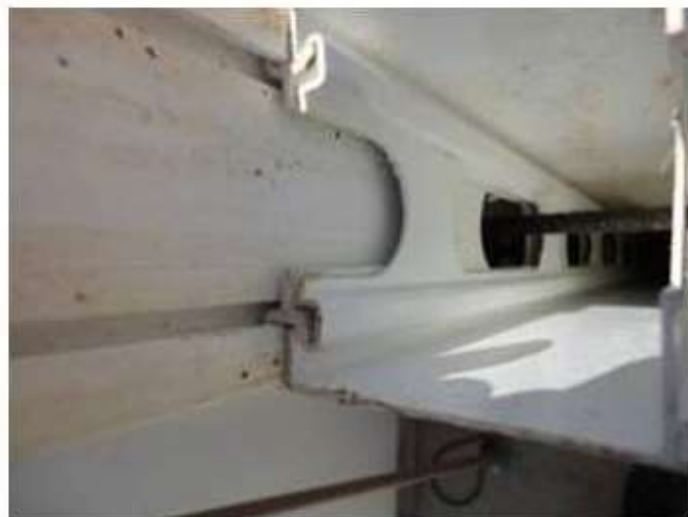
FIGURA 12 – Ferragem posicionada na região da contra-verga
